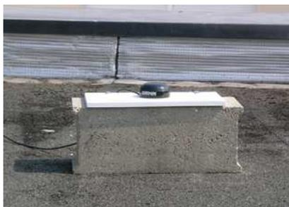
Elle est donc installée sur une grande terrasse sans aucune gêne possible et capte parfaitement tous les satellites. Elle est vissée sur une planche de contreplaqué marine peint, la planche est fixée sur un parpaing. Cette disposition permet un bon maintien de la balise et sa mise hors d'eau.
