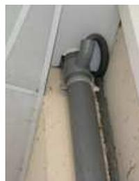
Le câble est récupéré par un trou pratiqué dans le tuyau d'écoulement sur lequel on a fixé une dérivation. Par un passage déjà existant il se retrouve dans le faux plafond de la petite salle.
