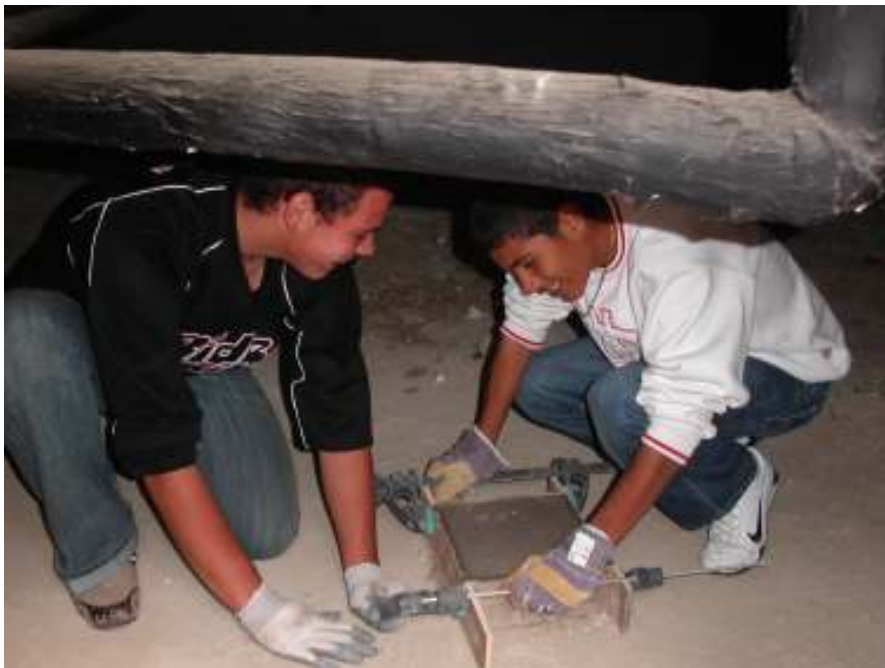
Préparation et réalisation de la dalle pour le sismomètre par des élèves
